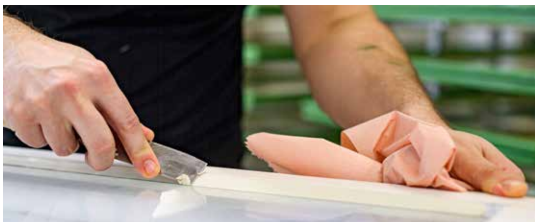
Handkittning med linoljekitt
